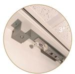
3°/ Tracer les différents points de fixation, et installer le support par rivet aveugle ou vis autoperceuse (haut. maxi 13 mm)
